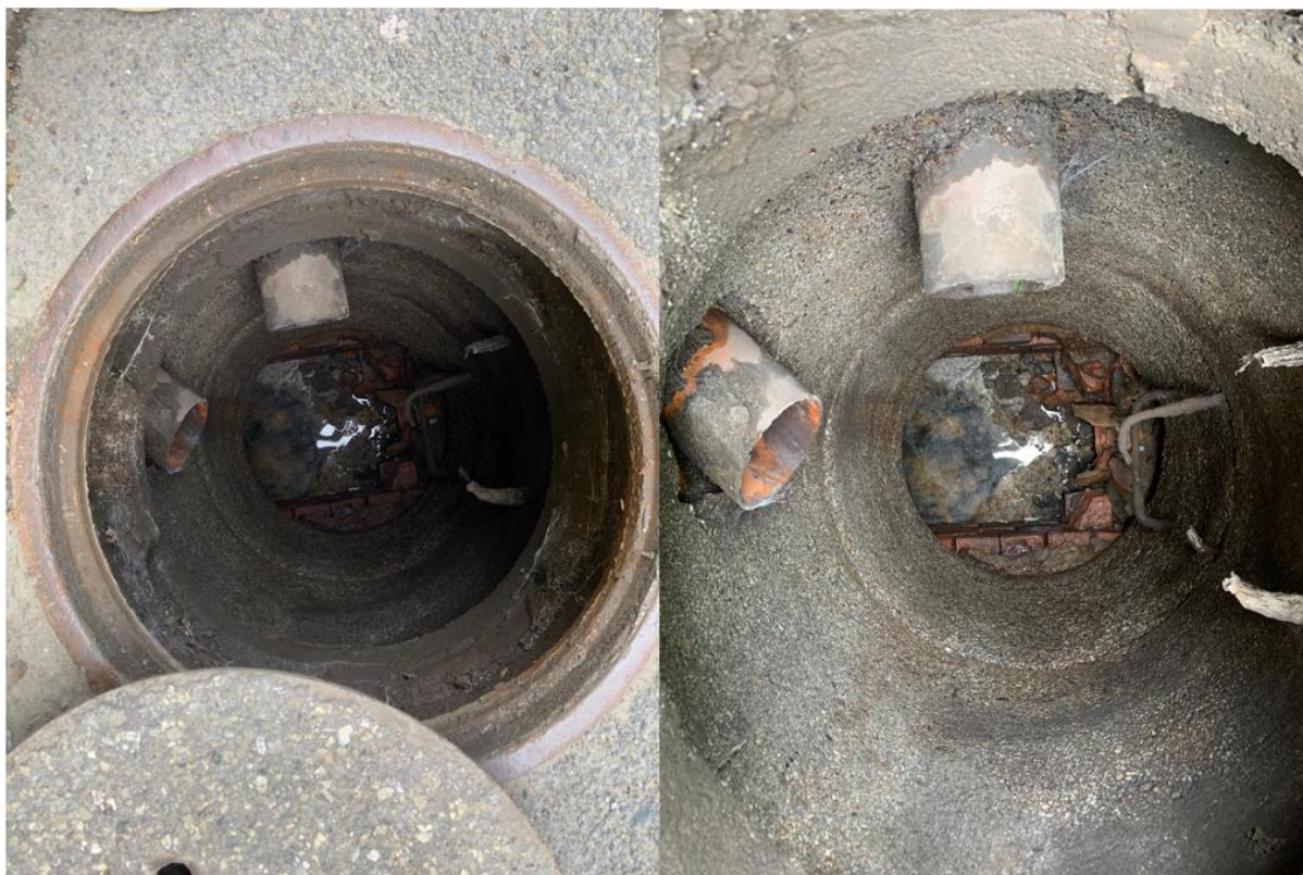
Obrázek 2 - Fotografie zachycující stávající stav kanalizační šachty umístěné mezi vstupy do objektu č. p. 37. V úrovni dna je do šachty zaústěn jeden přítok vedoucí kolmo od budovy. V úrovni pod konstrukcí vozovky jsou do šachty zaústěny dva přítoky dešťové kanalizace.
