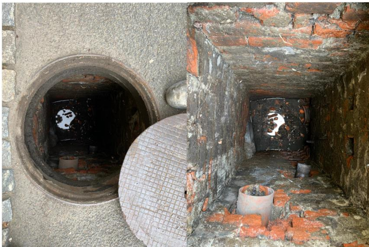
Obrázek 1 - Fotografie zachycující stávající stav kanalizační šachty umístěné před vstupem do železářství v objektu č. p. 37. V úrovni dna je do šachty zaústěn jeden přítok vedoucí kolmo od budovy. Mimo dno jsou do šachty zaústěny další dva přítoky kanalizace.
