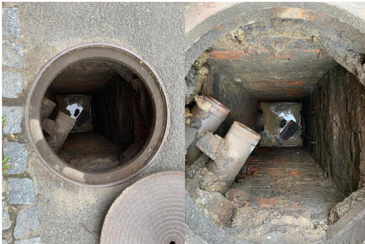
Obrázek 3 - Fotografie zachycující stávající stav kanalizační šachty umístěné před vstupem k bytům v objektu č. p. 36. V úrovni dna je do šachty zaústěn jeden přítok vedoucí kolmo od budovy. V úrovni pod konstrukcí vozovky jsou do šachty zaústěny dva přítoky dešťové kanalizace.
