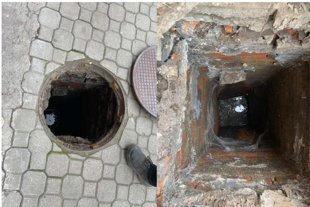
Obrázek 4 - Fotografie zachycující stávající stav kanalizační šachty umístěné před vstupem k bytům v objektu č. p. 34. V úrovni dna jsou do šachty zaústěny dva přítoky vedoucí rovnoběžně s průčelím budovy (vzhledem ke špatnému technickému stavu šachty nebylo možné trasu navazujícího potrubí ověřit, předpoklad vychází z vyjádření k existenci sítí vydaného společností SmVaK Ostrava, a. s.). Mimo dno je do šachty zaústěn další jeden přítok.
